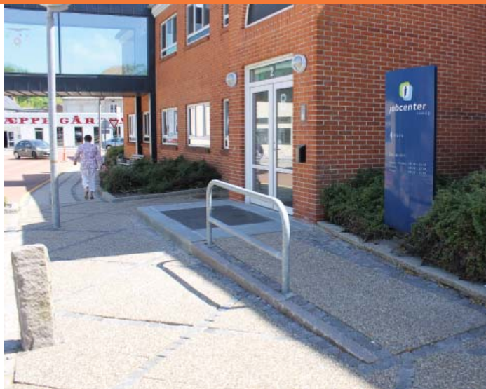
Lemvig - Niveaufri adgang til Rådhuset fra Rådhusstorvet, integreret i belægningen.
