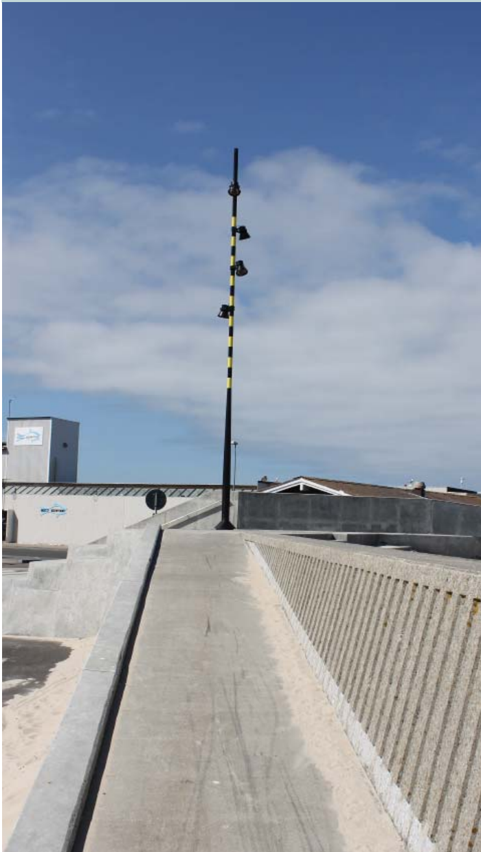
Thyborøn - Trappeanlæg med rampe mellem den gamle havn og badestranden. Udført i beton med opkant og ledeliner på reposen.
