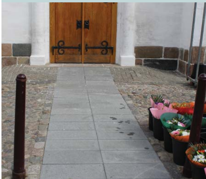
Lemvig - Niveaufri adgang til kirken i betonsten, integreret i brostensbelægningen.
