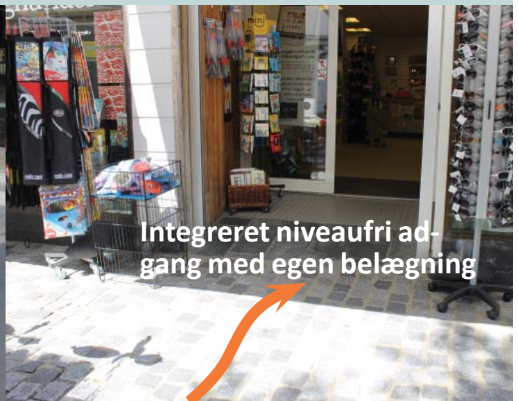
Lemvig - Belægning med chaussésten på den integrerede niveaufri adgang til butik i gågaden.
