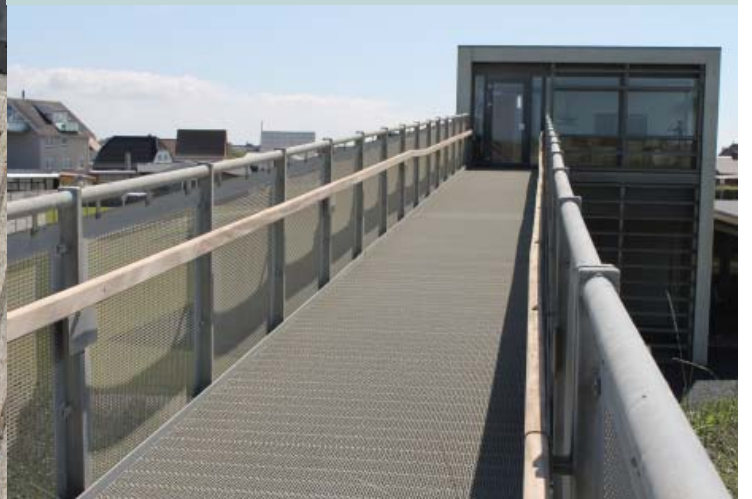
Thyborøn - Plejehjemmet i den gamle bydel har via udsigtstårn med gangbro direkte handicapvenlig adgang til diget og udsigten over Vesterhavet.
