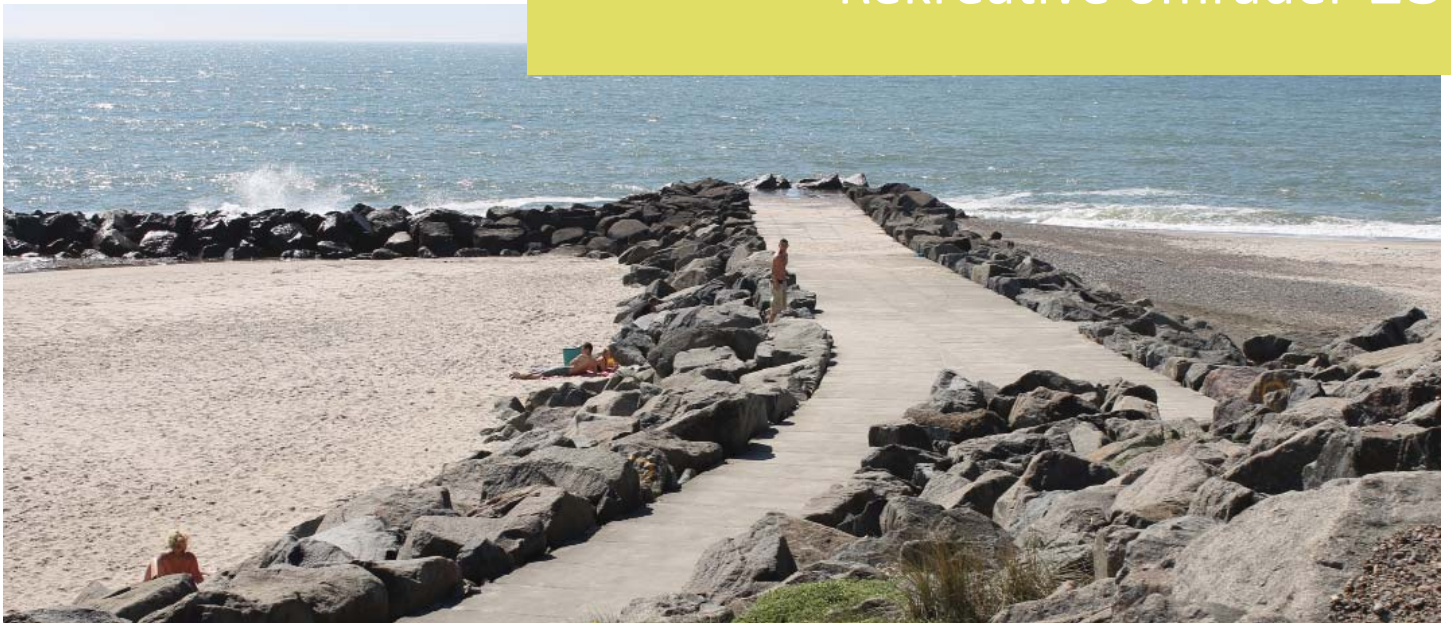
Fjaltring - Højde Q. Handicapvenlig bademole med adgang direkte fra parkeringsareal, udført i beton. Ved højte Q findes ligeledes handicapvenlig toiletbygning og shelters
