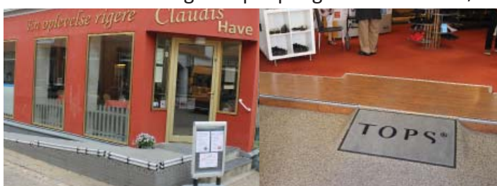
Lemvig - Udvendig rampe og indvendig rampe
